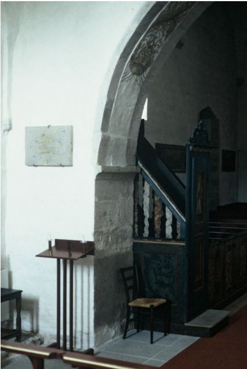
Bild 13. Der Chorbogen von Tingstäde Kirche auf Gotland vom Chor gesehen. Man sieht hier die Spur eines kleineren Bogen. Photo Anna Nilsén.
