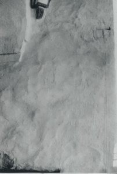
Bild 4. Übertünchte Spuren von abgesägten Balken sind in der Kirche von Nauvo (Nagu) in Finnland auf beide Seiten des Altars zu sehen. Diese rühren wharscheinlich von einer mittelalterlichen Altarschranke her. Photo Anna Nilsén.
