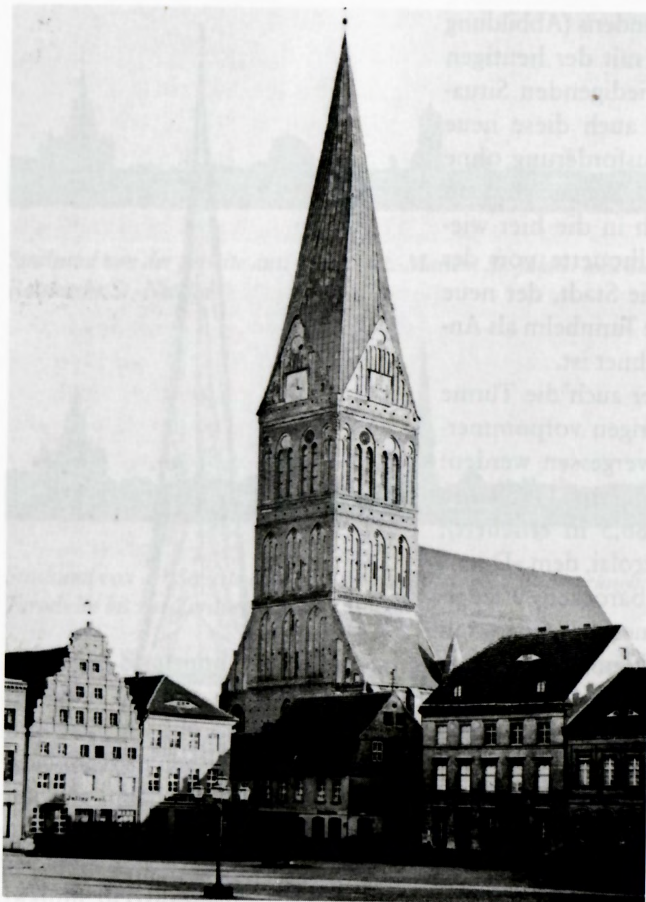
Anklam, St. Nicolai mit dem mittel- alterlichen Turm um 1870, besonders gut erkennbar ist die Drehung des Turmhelms.
