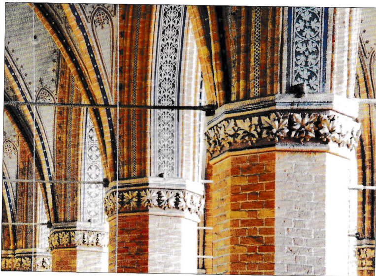
Kapitelle der südlichen Pfeilerreihe mit Ausmalung und Stukkaturen. Foto: Harald Pepel, Demmin, jetzt Steinberg/Sachsen
