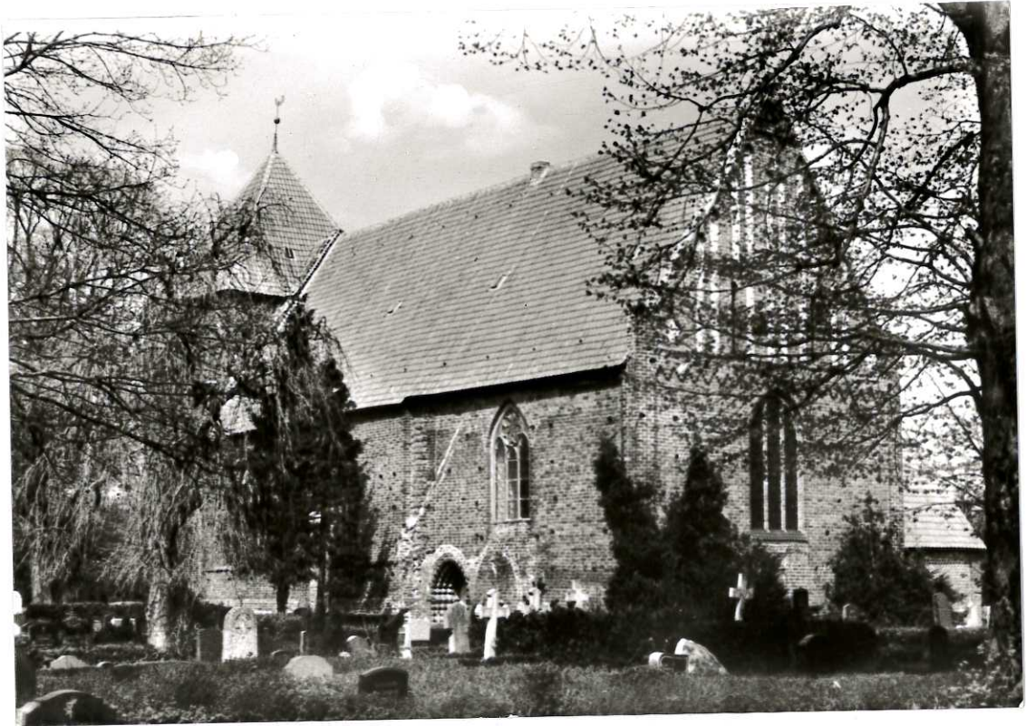
Neukirchen bei Greifswald Die Dacheindeckung durch die „Dorfkirchenspenden“ gefördert
