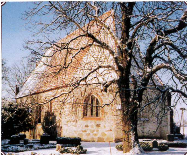
Kreuzmannshagen Die Chorfenster konnten über die „Dorfkirchenspenden“ ermöglicht werden.
