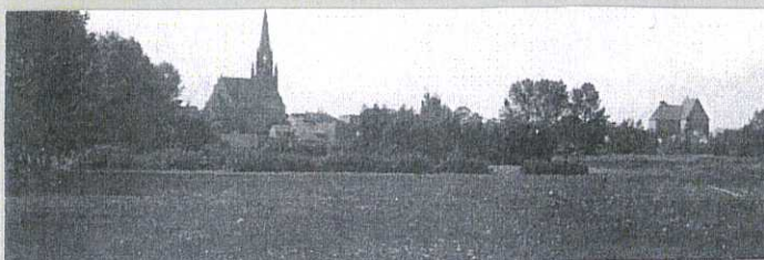
Blick von Nordosten auf Kirche und Stadt aus dem Peenetal
